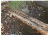
Начало было положено ещё в прошлом году разборкой старого. Теперь, вместо последних брёвнышек, в канаву уложили специальную трубу. Новый мост будет насыпного типа.
